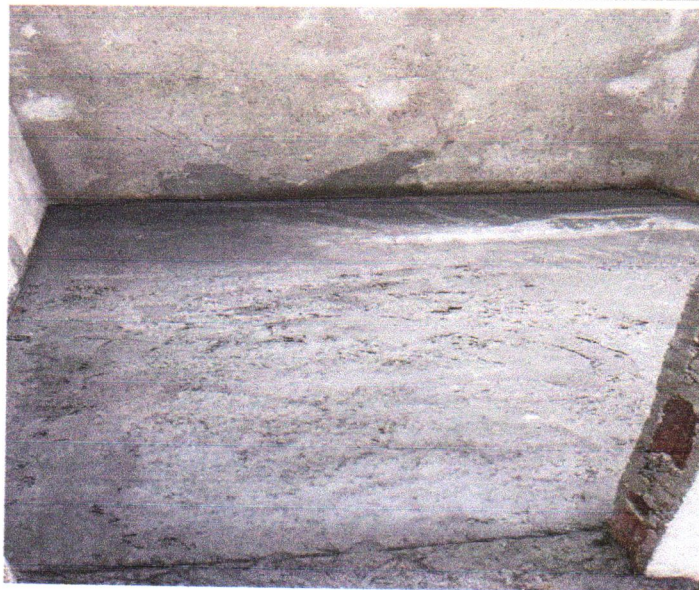
FOTO 121: IMPERMEABILIZAÇÃO DE PISO COM ARGAMASSA
