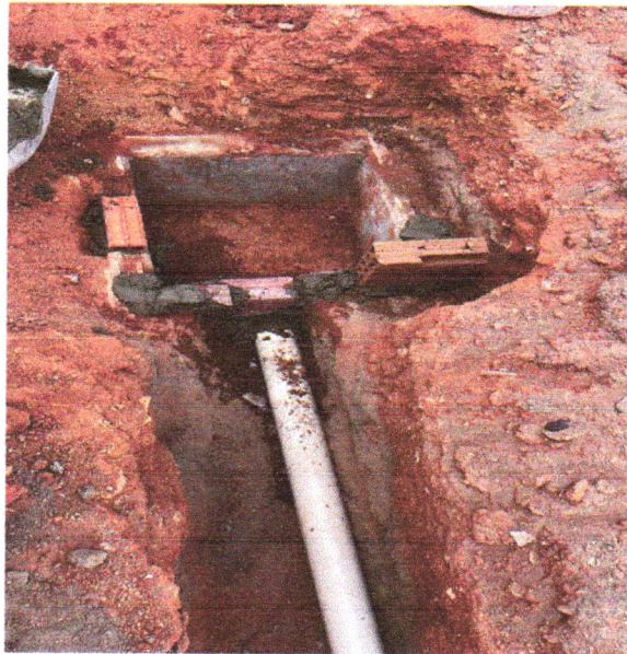
FOTO 120: LIGAÇÃO PROVISÓRIA DE ESGOTO
